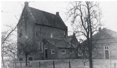
Het Spieker na de restauratie
